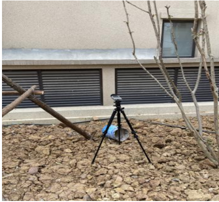
18#住宅楼排风口噪声
