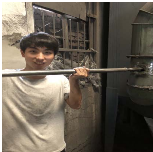
抛丸粉尘排气筒进口
