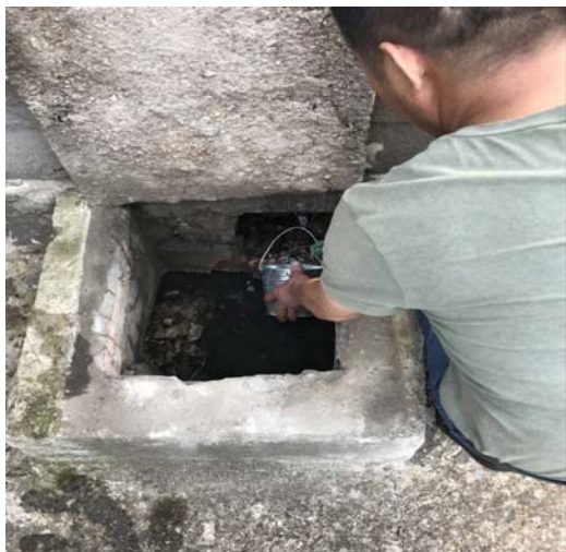
厂区废水总排口
