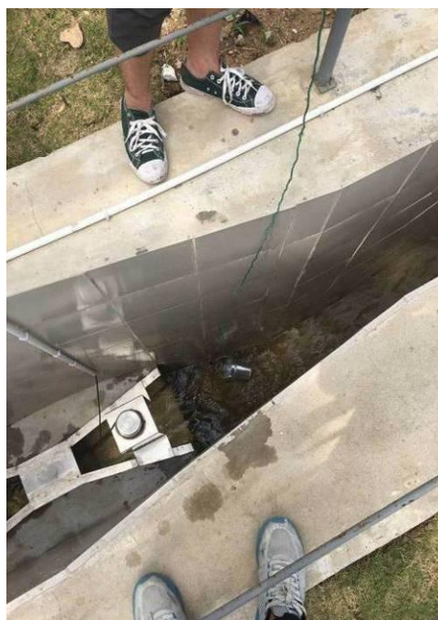
污水处理站出口
