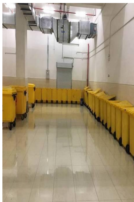
医疗废物储存点
